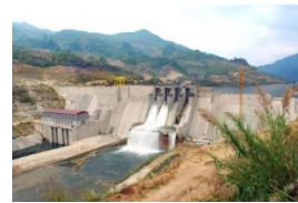
Bắc Hà Hydro power plant
